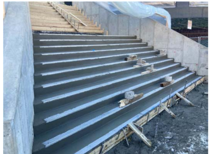
Grande Stairs bottom ¼ poured
